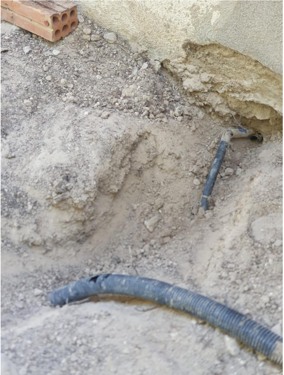
Excavación que han hecho para buscar la corriente eléctrica.
